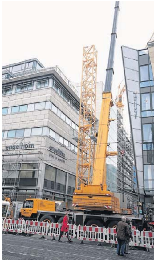
Bald erledigt: Ein Autokran hilft, vor O 5 einen Baukran aufzustellen. BILD: PROSSWITZ
