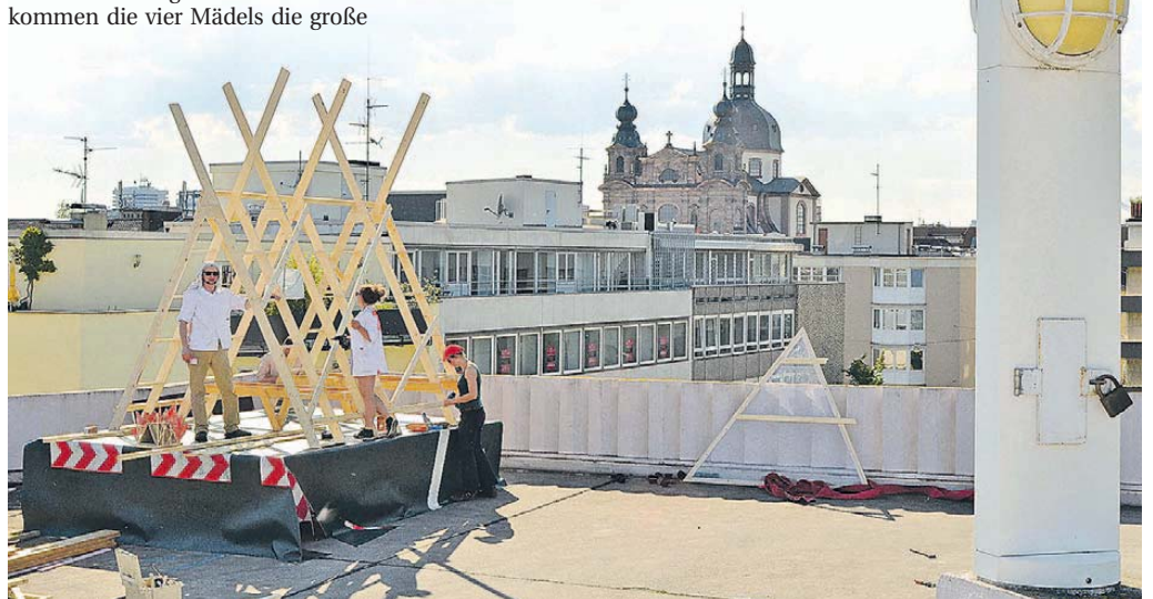
Das Team von „Feuer und Flamme“ baut sein Zimmer auf dem Dach des Parkhauses N2. BILDER: SOHL
